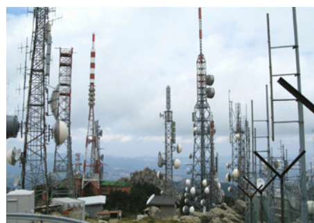
Mobilfunktürme stehen nicht nur einzeln verstreut in der Landschaft herum, sondern werden vielerorts in grossen Gruppen mehrerer „Anbieter“ aufgebaut.
