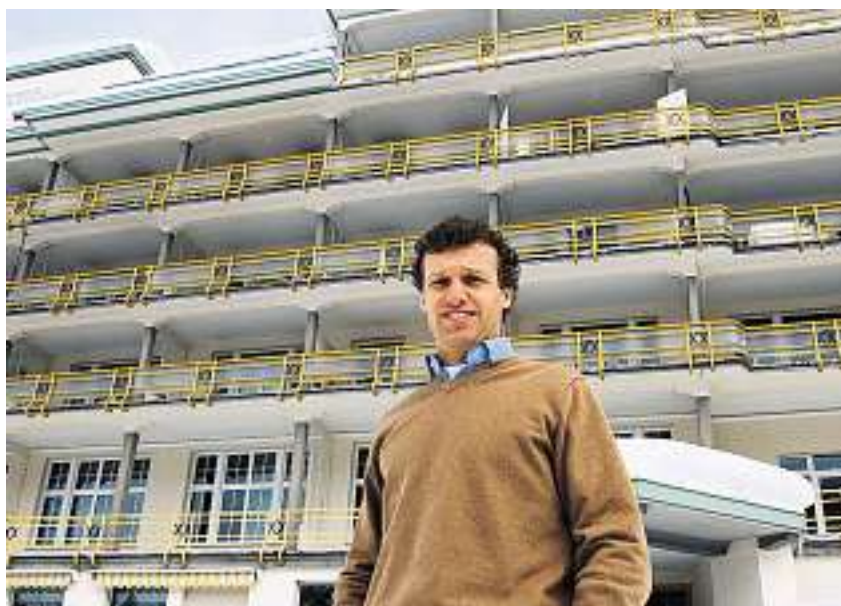
Vom Um- zum Neubau: Der Investor Dennis van der Valk wird das ehemalige Niederländische Asthmazentrum abbrechen müssen.
